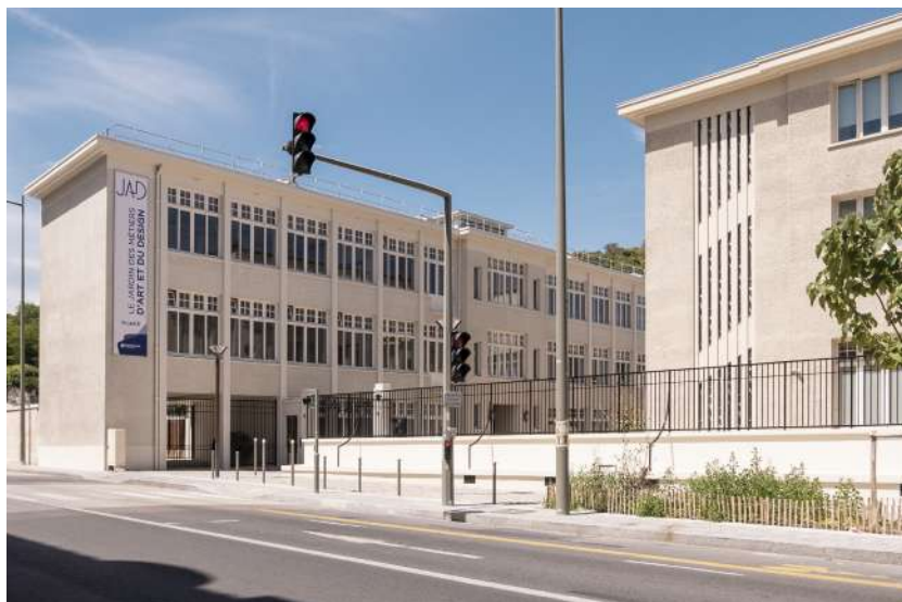
Accès principal du JAD - Bâtiment Roux-Spitz ©Eglantine Aubry
